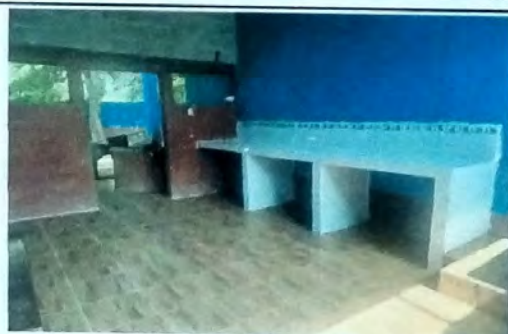
Foto 3: MODULO B COCINA Instalacion de piso ceramico + elaboracion de mueble de concreto con revestimiento de azulejo.
