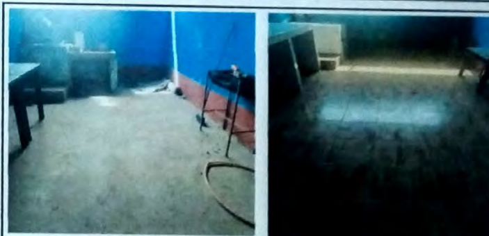
Foto 4: MODULO B COCINA Instalacion de piso ceramico
