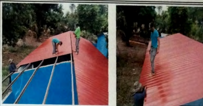
Foto 8: MODULO AULA mantenimiento de estructura metalica y cambio de lamina de zinc por lamina troquelada cal 26.
